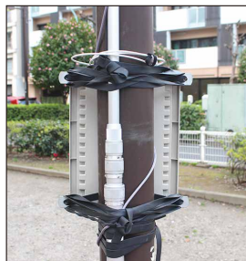
ゴムバンドで支柱に固定
